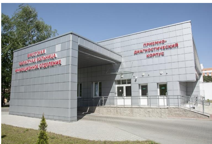
Реконструкция и оснащение приемно-диагностического корпуса инфекционного отделения Брестской областной больницы, г. Брест, Брестская область, 2021 г.
